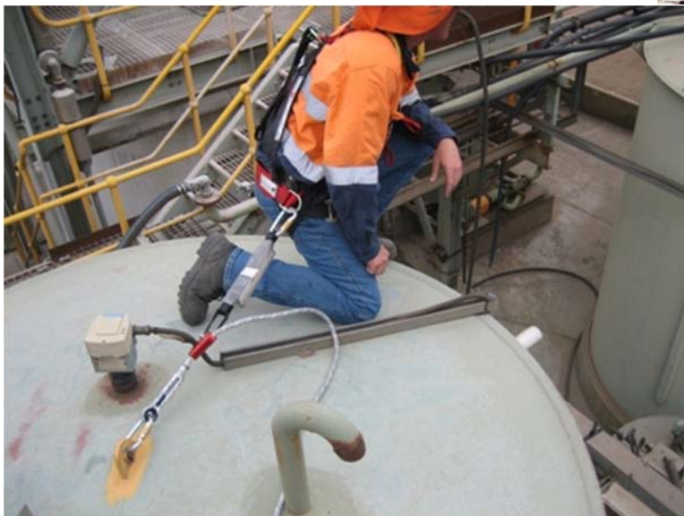
شکل ۵۴-۳- محدود کننده با اتصال یک طناب
