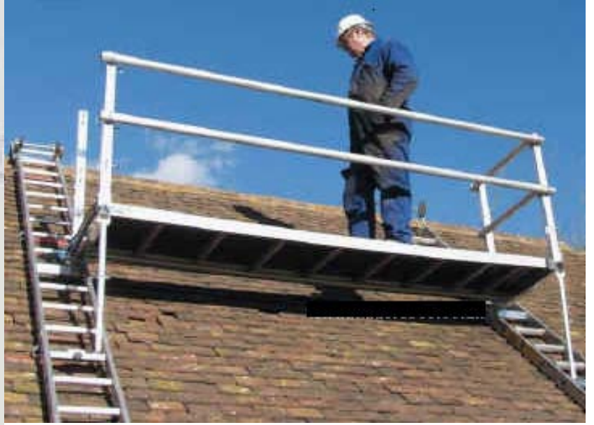
شکل ۳۰- جایگاه کار روی سطوح شیبدار
