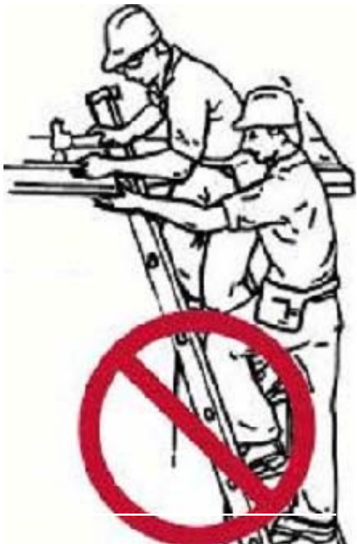
شکل ۱۲- استقرار همزمان دو نفر ممنوع
