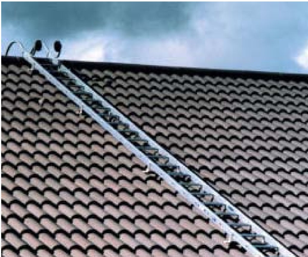
شکل های ۱-۳ نردبان سقفی ، نحوه استقرار
