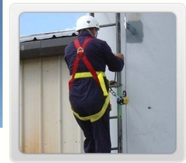
شکل ۷۴- صعود از نردبان با ابزار متوقف کننده
