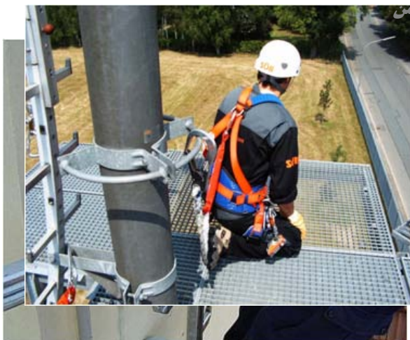
شکل ۱۱۱ - سامانه محدود کننده با استفاده از ریل
