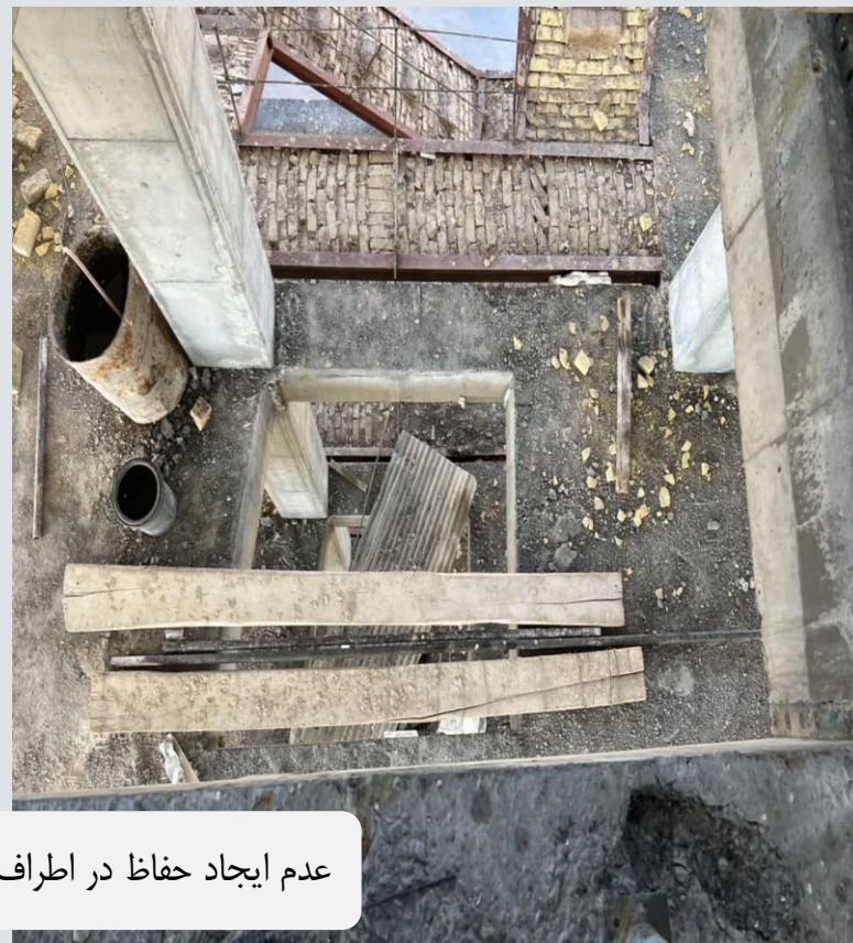
دسترسی نامناسب و پرخطر به سقف
