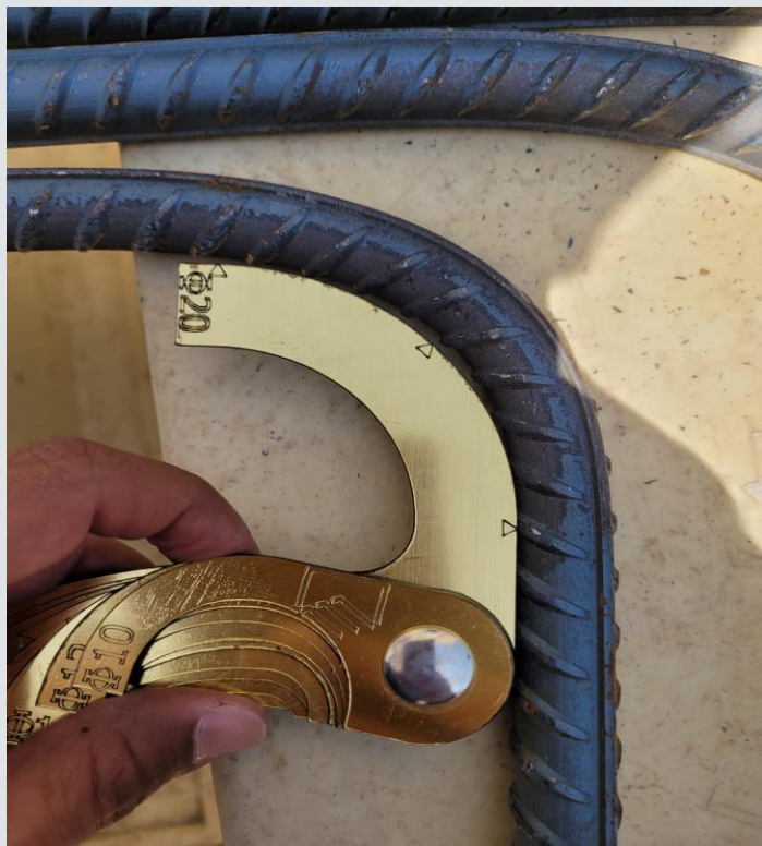
رعایت شعاع خم استاندارد میلگرد
