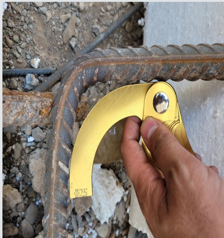
عدم رعایت شعاع خم استاندارد میلگرد
