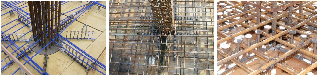
شکل ۵-۱۳: استفاده از انواع SSR به عنوان میلگرد برشی در دال
